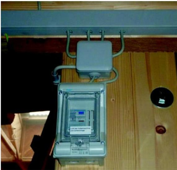
IC 52 Kabel in Rohre
