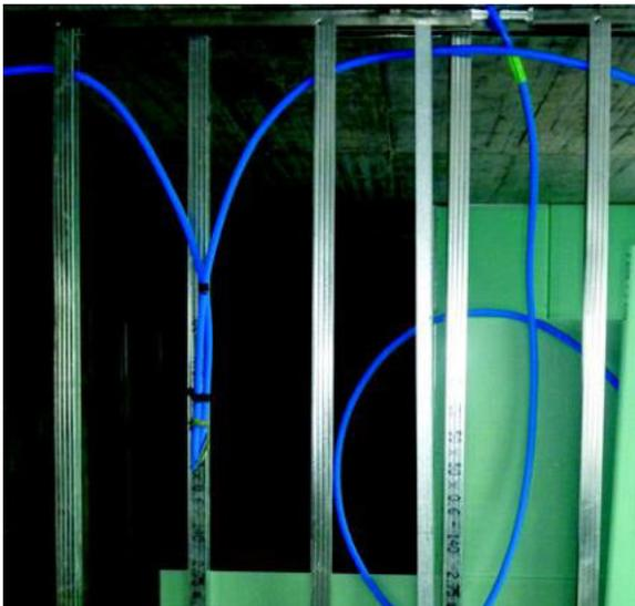
IC 22 Installationsrohre in Wand mit Hohlraum
