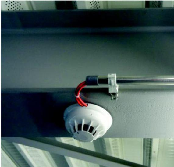
IC 13 Brandmelder-Sockel auf Metallkonstruktion
