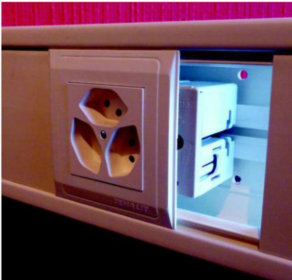
IC 31 Steckdose T13 dreifach in modulare Systeme (Brüstungskanal)
