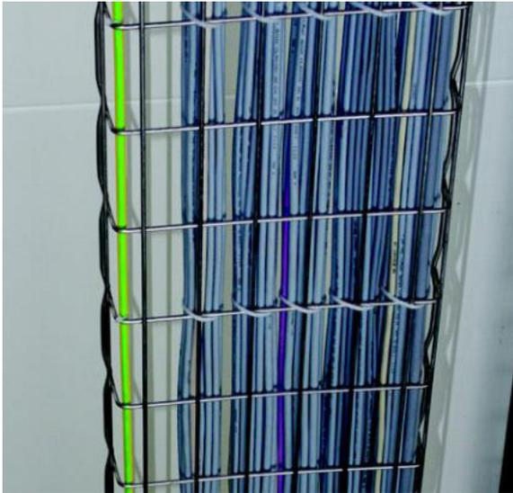
IC 53 Kabel auf Kabelkanal
