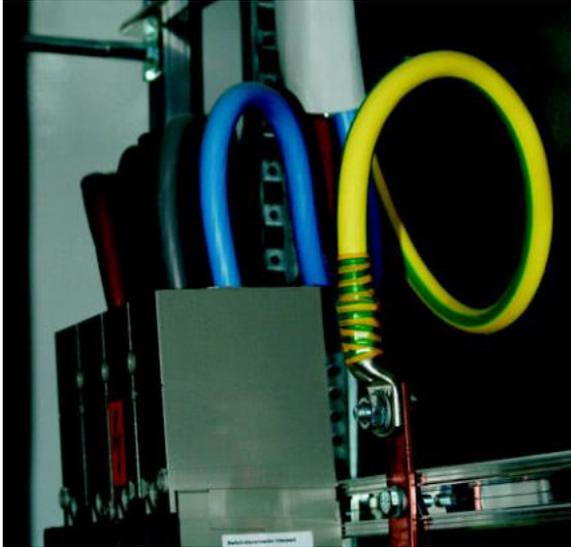
IC 73 Kabelanschluss mit Kabelschuhen
