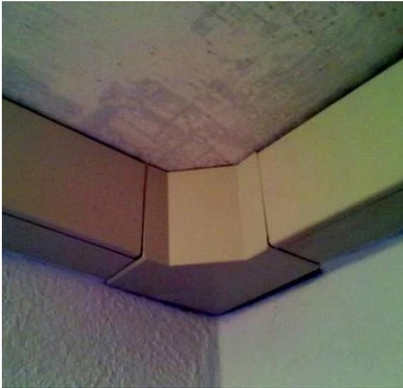
IC 12 Installationskanal auf Backstein
