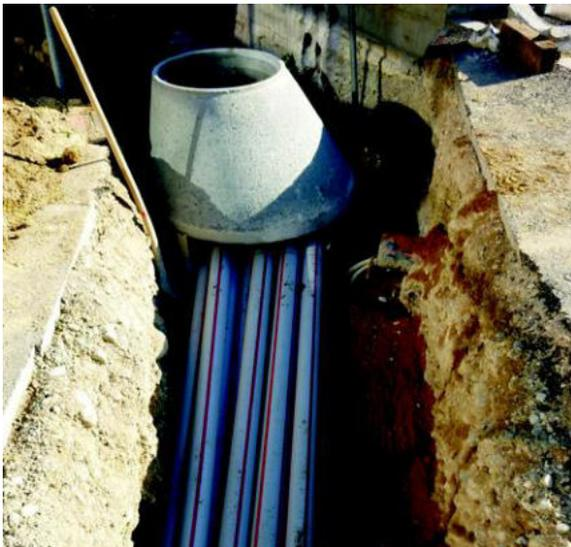
IC 20 Kabelschutzrohr KRS in vorhandene Gräben
