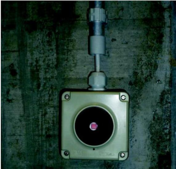
IC 12 NAP-Schalter leuchtend auf Beton
