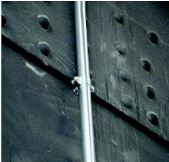
IC 13 Alu-Rohr auf Metallkonstruktion
