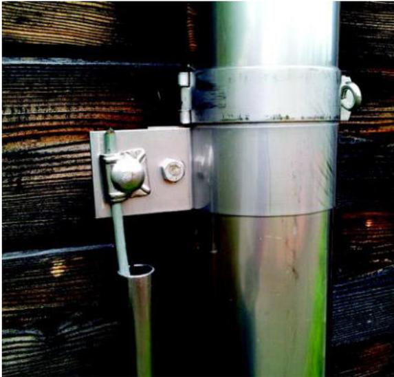
IC 11 Verbindung an Rohrleitung (Ableitung)
