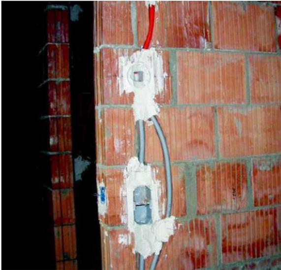
IC 22 Installationsrohre und Einlasskästen in Wände aus Backstein
