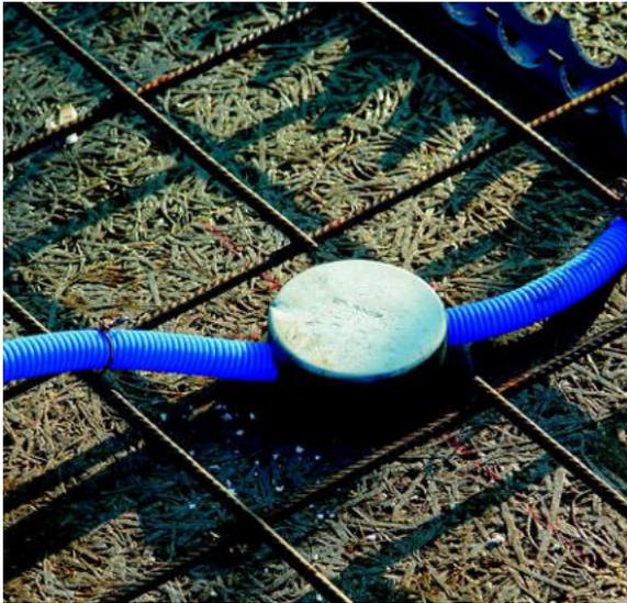
IC 21 Installationsrohre in Deckenschalung
