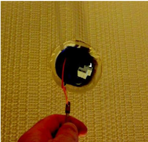
IC 53 Einzug Drähte in Rohre, die Drähte enthalten (Nachzug)
