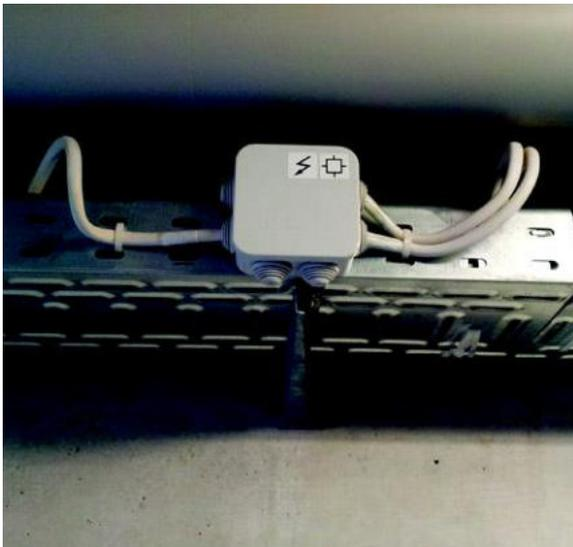
IC 11 AP-Abzweigkasten KS auf nicht zu bearbeitenden Montagegrund (Kabelbahn gelocht)
